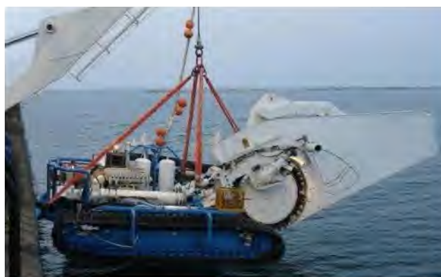
Trancheuse mécanique à roue (Crédit photo Rte)
