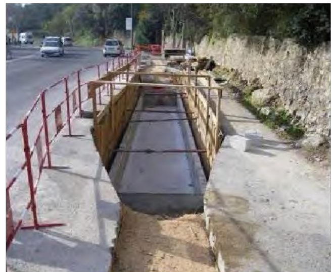
Chambre de jonction sous voirie (Crédits photos et image Rte)
