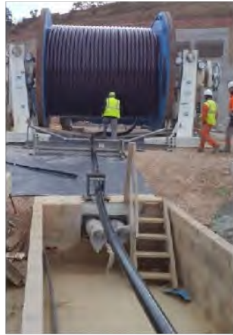
Pose de liaison souterraine sous voirie (Crédit photos Rte)
