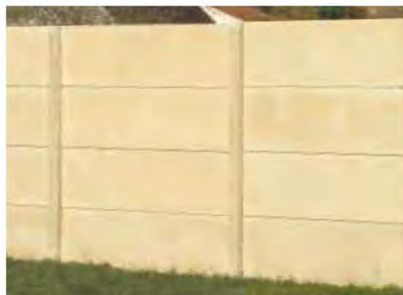
Modèle de clôture pleine - panneaux de béton teinté dans la masse ton pierre
