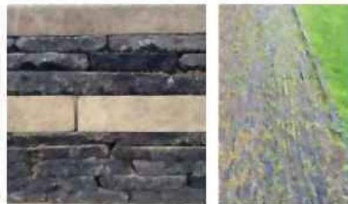
Muret et noues façon «pierre sèche» en enrobé recyclé
