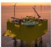
Une station de conversion sur une plateforme en mer
