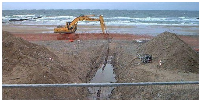
Forage dirigé ou Tranchée sur l'estran (Crédit photos Rte)
