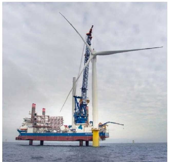
Installation d'une éolienne en mer par un navire jack-up pour le parc éolien de Dudgeon (Source : Siemens Gamesa Renewable Energy)
