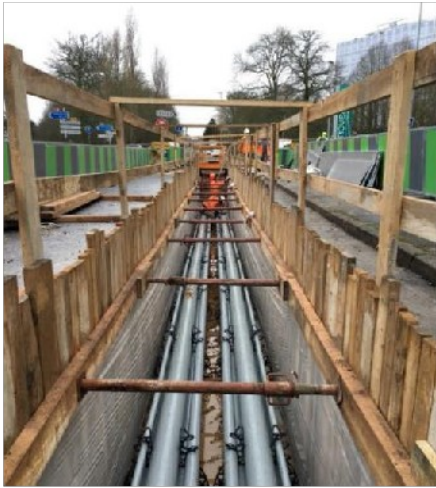
Pose de liaison souterraine sous voirie (Crédit photos Rte)
