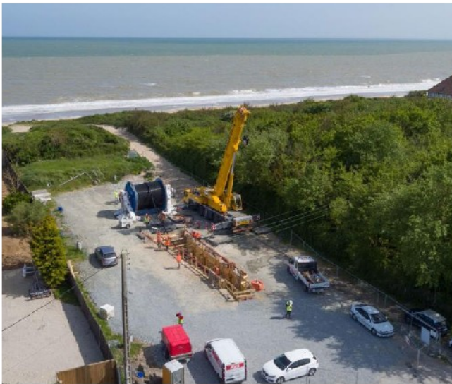
Exemple d'une chambre de jonction d'atterrage avant comblement (Interconnexion France-Angleterre IFA2) (Crédit photo Rte)
