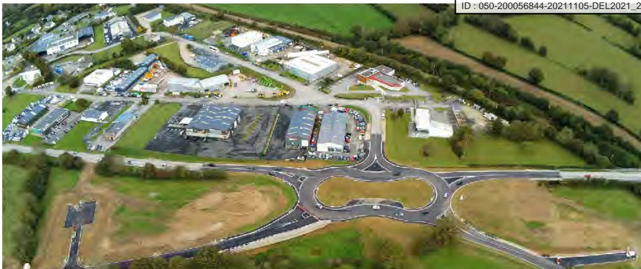
Vue de la réalisation du nouveau rond-point aux abords de la ZAEE Grande Fontaine à Martinvast.
