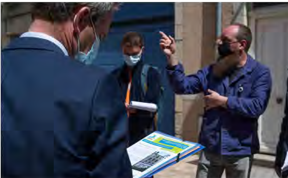
Visite d'un chantier dans le cadre de l'Opération Programmée d'Amélioration de l'Habitat.
