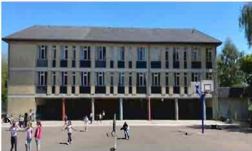
Photo de la façade Ouest existante
