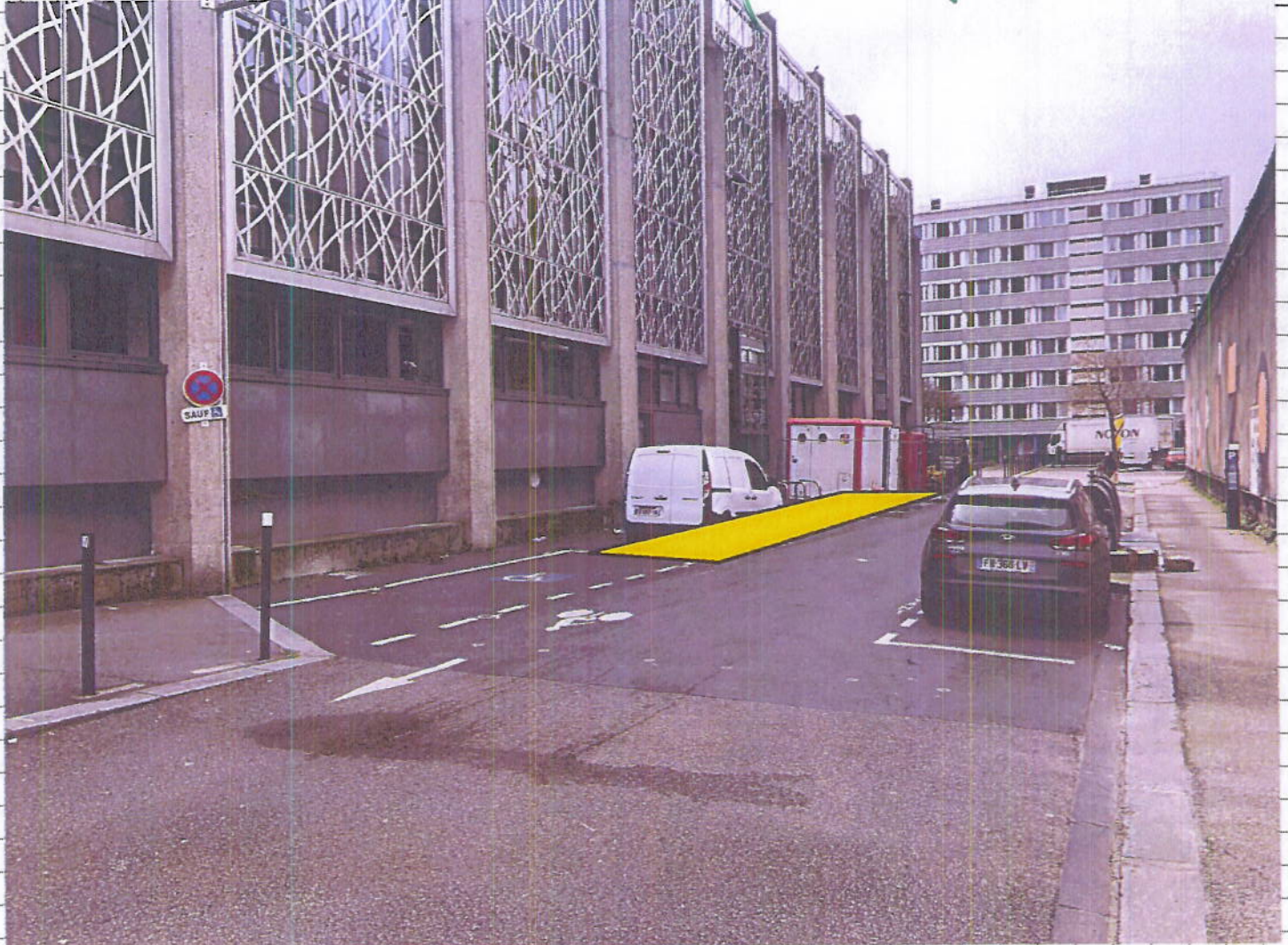
Zone de stockage des engins de chantier le week-end
