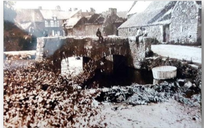
Figure 2: Par la suite, création d'un barrage artisanal. Pierres mises en place pour créer un seuil à l'aval du pont (lavage du linge...). Après chaque crue, récupération des pierres en aval.
