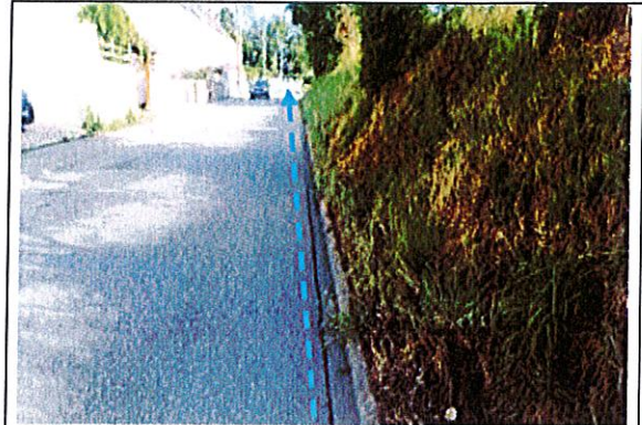
GC sous chaussée
