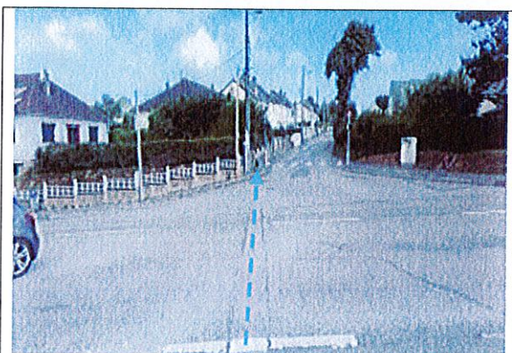
GC sous chaussée
