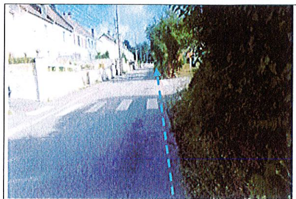
GC sous chaussée
