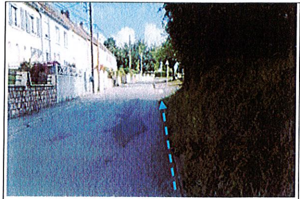
GC sous chaussée
