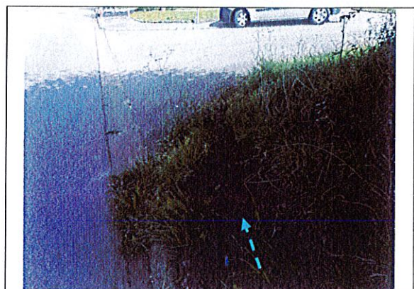
GC sous accotement vers chambre FT N°2773
