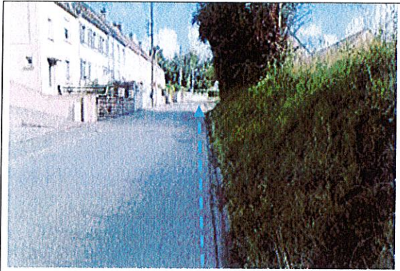
GC sous chaussée
