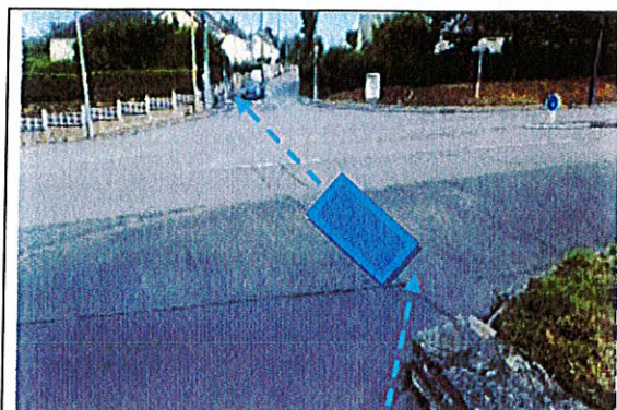
GC sous trottoir depuis chambre FT N°2456 Vers GC sous chaussée
