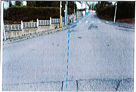
GC sous chaussée
