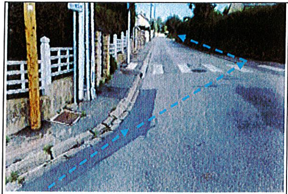
GC sous chaussée
