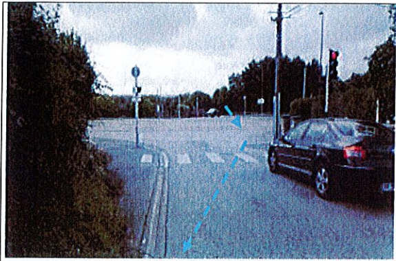
GC sous chaussée
