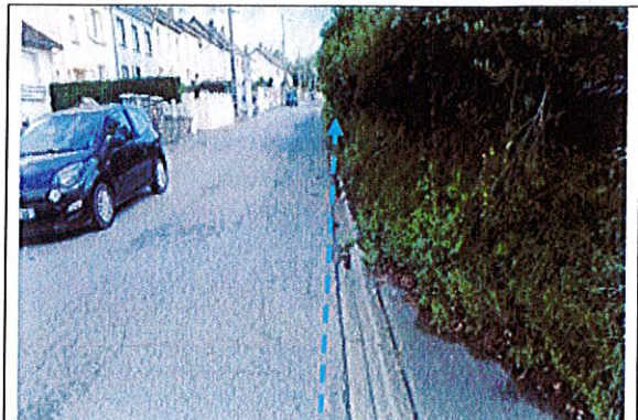
GC sous chaussée
