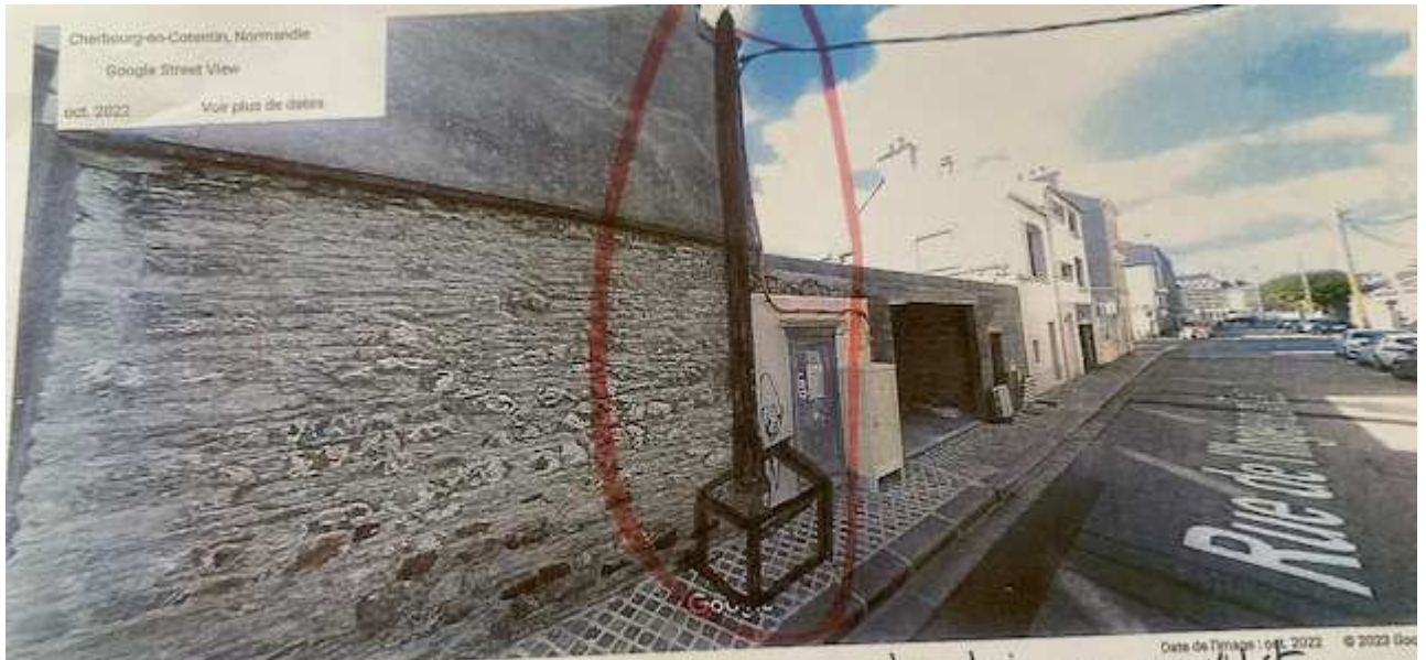
Installation de l'alimentation de la base vic sur un poteau bois avec massif béton.
