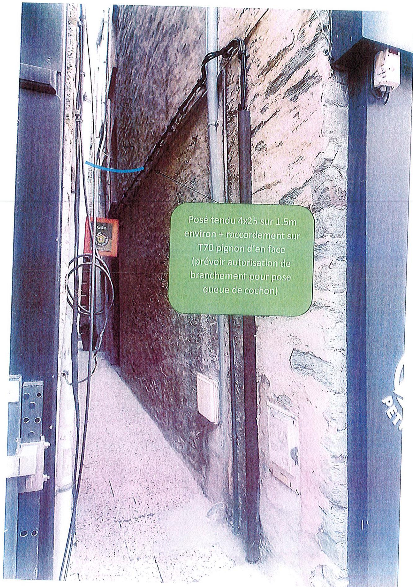
Posé tendu 4x25 sur 1.5m environ + raccordement sur T70 pignon d'en face (prévoir autorisation de branchement pour pose queue de cochon)
