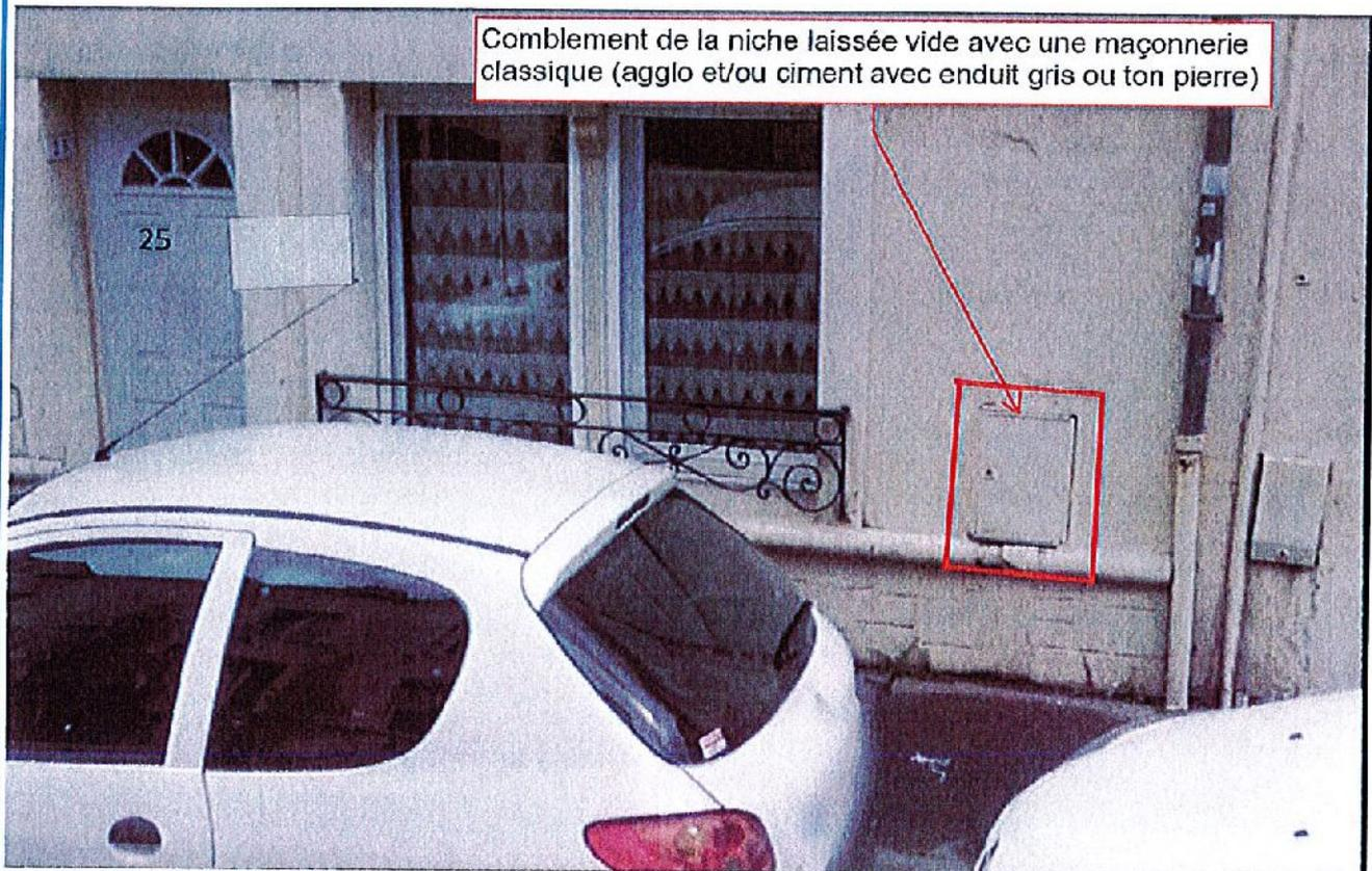
Comblement de la niche laissée vide avec une maçonnerie classique (agglomération et/ou ciment avec enduit gris ou ton pierre)
