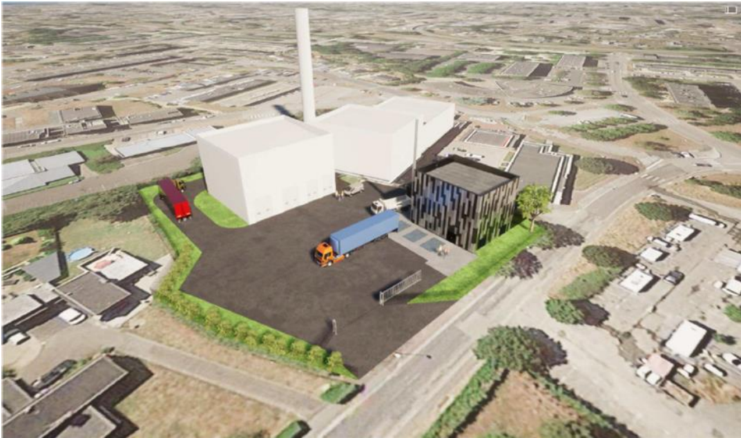
Vue aérienne de la nouvelle chaufferie
