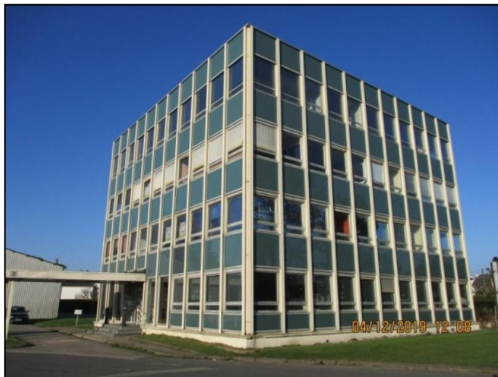
Immeuble « TOUR HELIOS »
