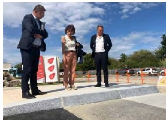
Le revêtement des futurs quais du Bus
