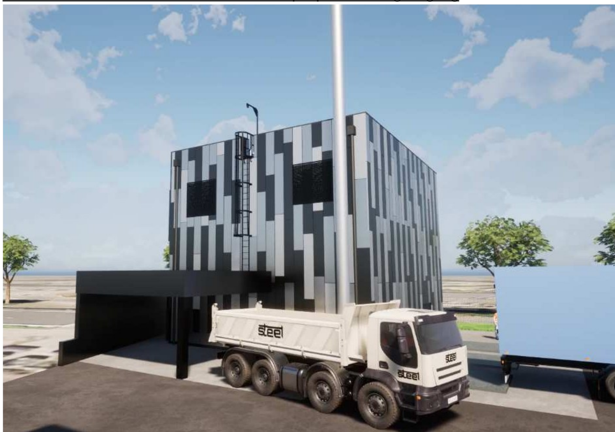
Vue zone benne à cendre et auvent métallique pour stockage bigbag
