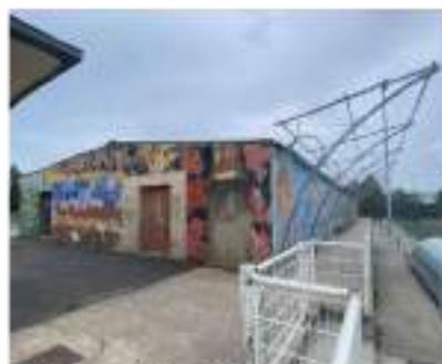
Anciens vestiaires à démolir
