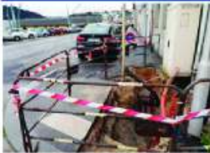
→ Un chantier aux Quaiés III en cours depuis septembre pour le renouvellement des réseaux HTA et basse tension.
