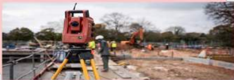
Lancement de la construction du Centre aquatique de Valognes
