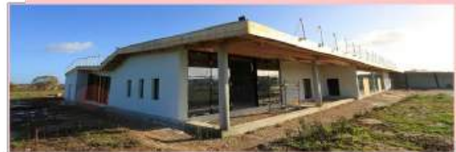
Construction du pôle enfance de Montebourg
