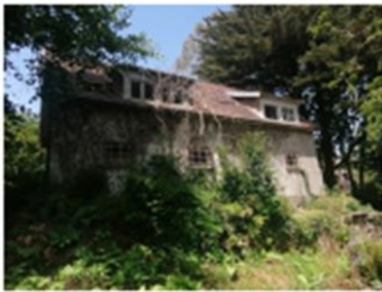
Vues façade arrière (sud est)
