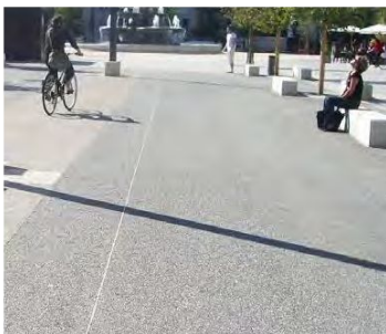
Enrobé noir granulat blanc des voiries
