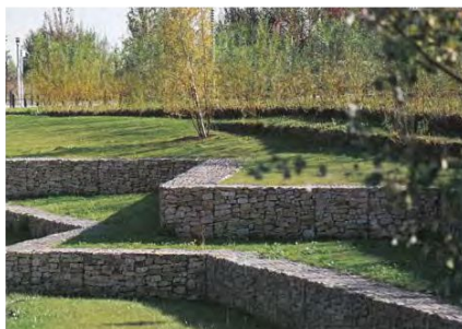
Mur de soutènement en gabion des voiries et espaces publics
