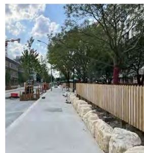
Enrochements en grès de la carrière de l'Ouest des voiries, espaces publics et gestion des eaux
