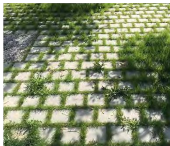
Pavés béton à joints enherbés des stationnements
