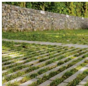
Dalles joints enherbés des places et parvis
