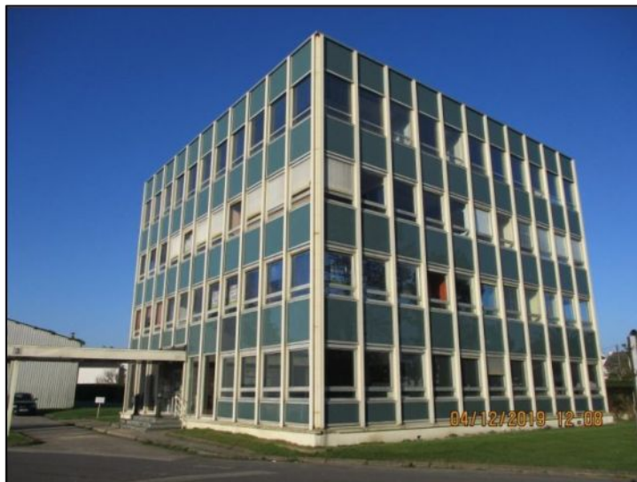
Immeuble « TOUR HELIOS »
