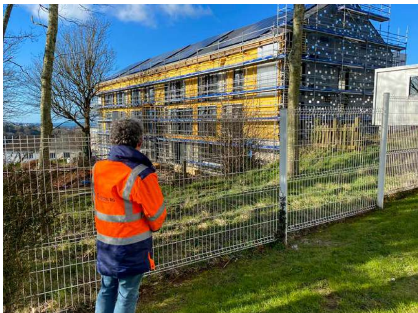
92 panneaux photovoltaïques ont été posés début mars sur le pan sud-ouest de la toiture de Mosaïque.
